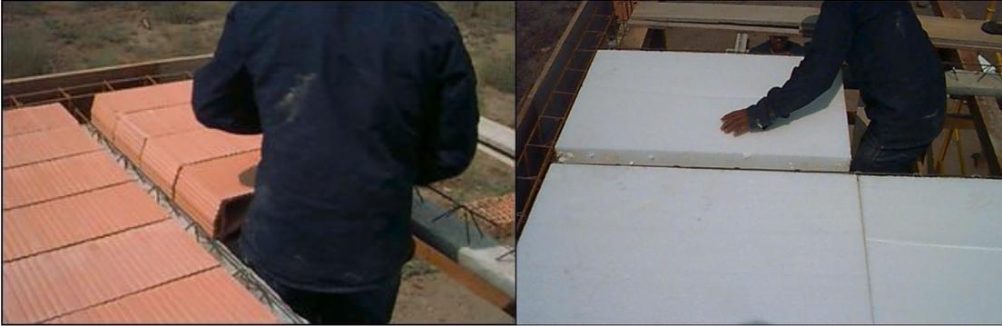
Su función es eliminar la cimbra de contacto, aligerar la losa, aislante térmico y acústico, obteniendo más seguridad y calidad en la aplicación de este sistema constructivo.
