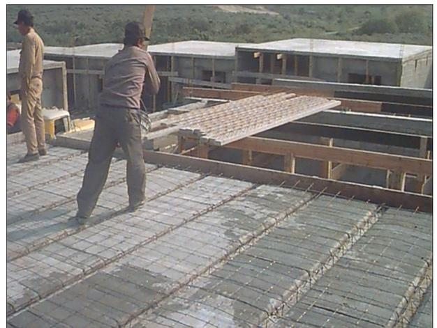
Las viguetas se colocan manualmente sobre el muro ya nivelado.
