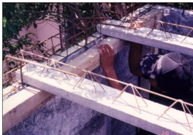
Para dar la separación adecuada de las viguetas, se coloca una bovedilla en cada extremo y se juntan bien las viguetas que la sostienen.
