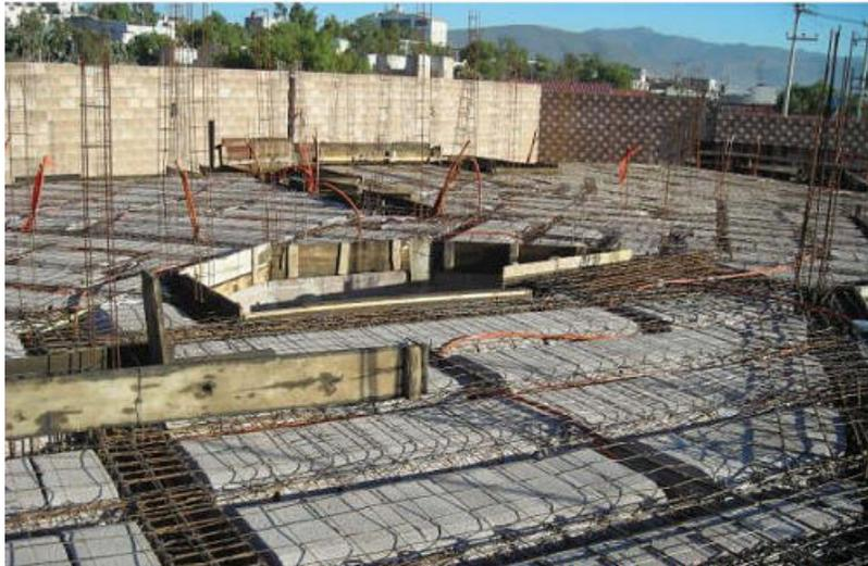
Con alambre recocido se amarra a cada 50 cm. a la varilla superior de la armadura.
