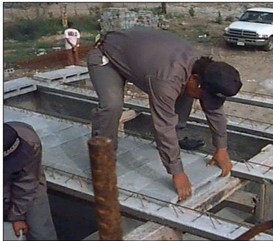
Las bovedillas de los extremos deben apoyarse al menos un centímetro. En el caso de que el entre-eje del extremo sea menor que el ancho de la bovedilla, estas se cortan y se apoyan sobre el muro.
