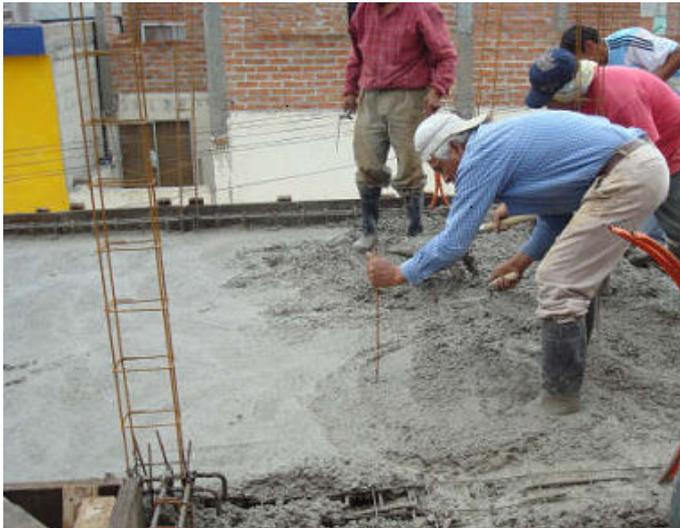
Al realizarse el colado, del concreto en la obra, las diagonales de la armadura funcionan como conectores entre el concreto recién colado y el patín de la vigueta, integrado en una pieza, la vigueta con la capa de compresión (como si todo se uniera y fabricara al mismo tiempo).
